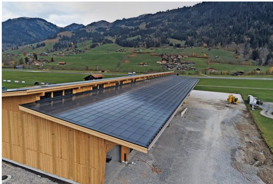
Das Süddach der neuen Simmental-Arena liefert Solarstrom für 45 Haushaltungen.
